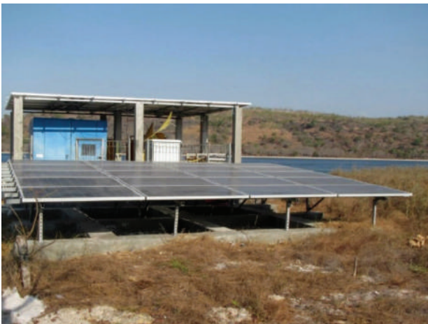
Fasilitas panel listrik tenaga surya di pesisir Desa Marisa (Kangge), Alor, NTT
