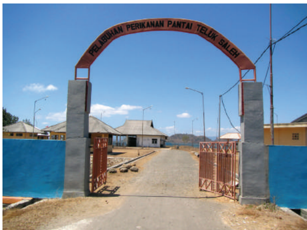
Pelabuhan Perikanan Pantai Teluk Saleh di pesisir Desa Teluk Santong, Sumbawa, NTB
