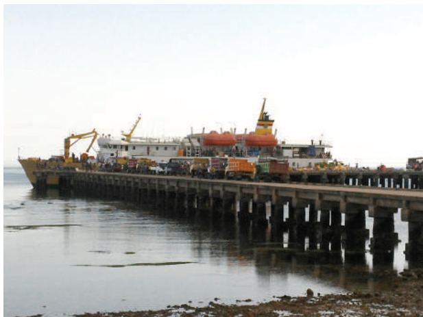
Dermaga pelabuhan di Desa Wonreli, Pulau Kisar, MBD
