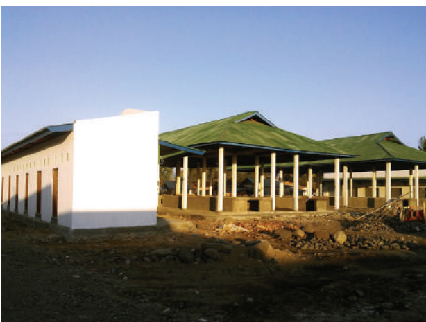
Fasilitas TPI di Desa Nanga Dero, Nagekeo, NTT
